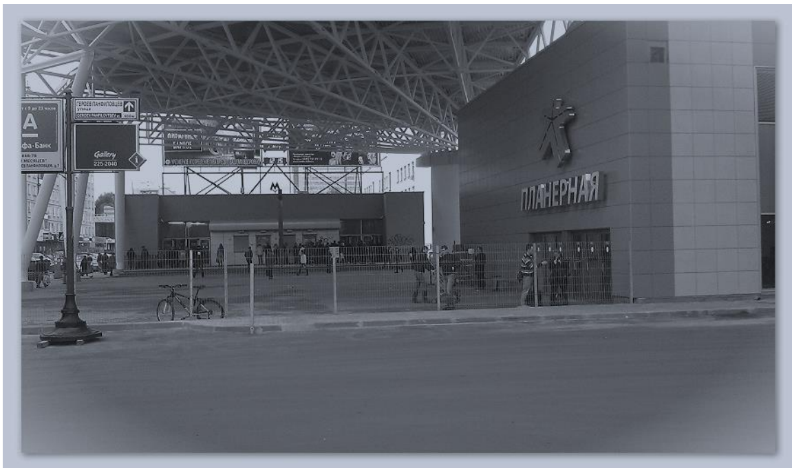
Рисунок 5.4. ТПУ «Планерная» в г. Москва: здание торгового комплекса и перекрытый забором переход между станцией метрополитена и автобусными остановками
